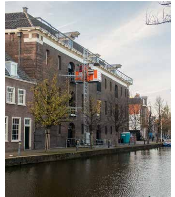
De ligging aan het water maakt de bouwplaats beperkt.
